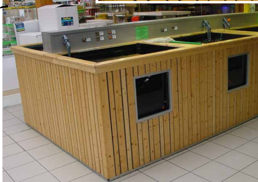
Abb. Verkleidung mit lasierten Fichteleisten und Schattenfugen
